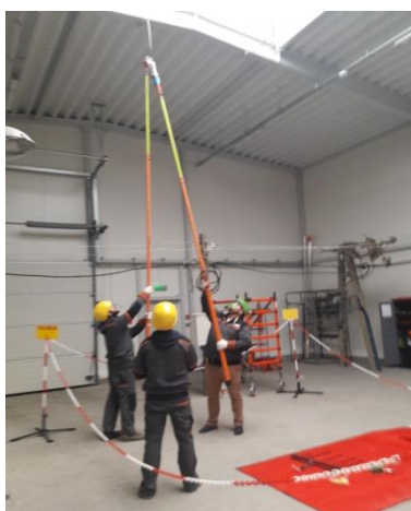
Fot. Pokaz przecinania przewodu roboczego linii ŚN w technice PPN.
