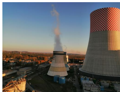
Fot. Widok z góry na chłodnie kominowe – nowa (180 m wysokości, średnica u podstawy 144 m)
